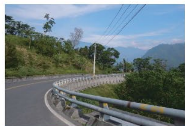
斜坡轉彎道路
